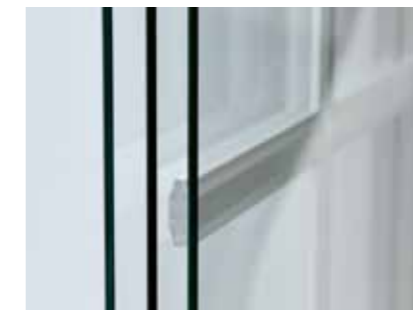
In den Glaszwischenraum eingelassene Sprossen (SZ).
